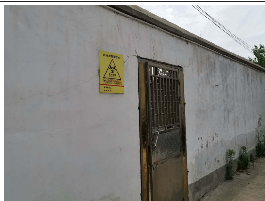
危险废物暂存处
