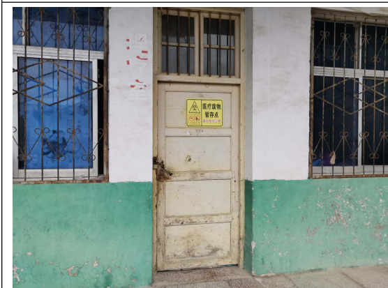
医疗废物暂存处
