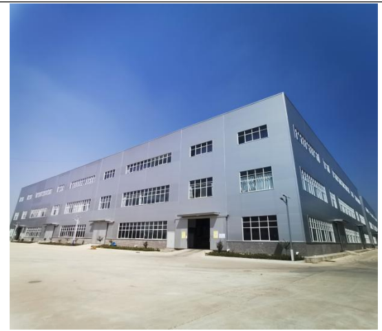
扩建项目 8#厂房
