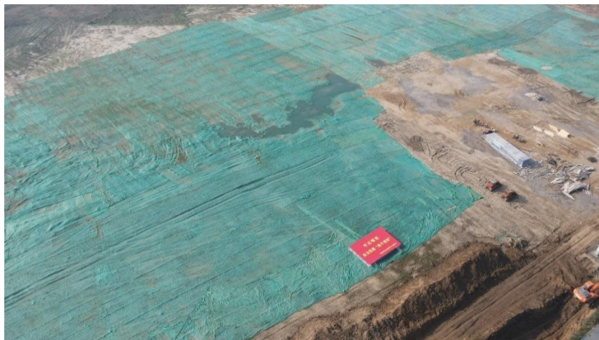
平煤神马超精细精钢石加工项目（在建）
