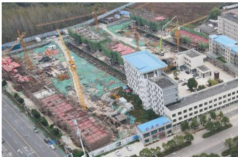
光山县弦丰粮油有限公司（在建）
