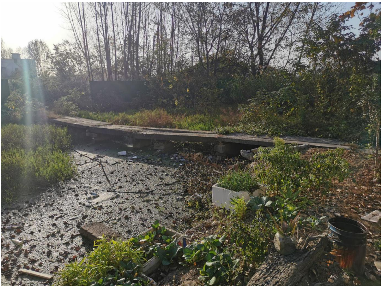
照片 014 王寨石桥 2
