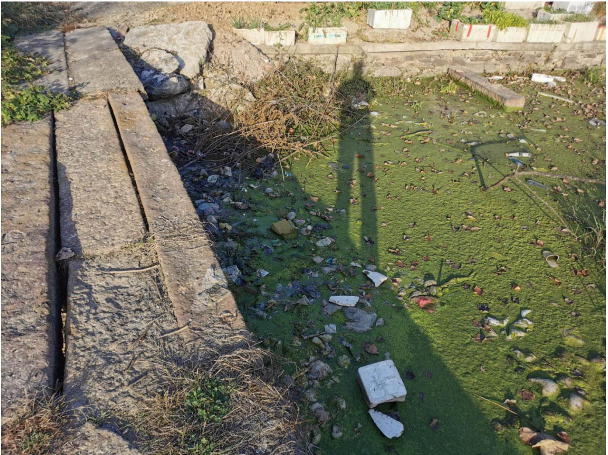
照片 016 王寨石桥 4
