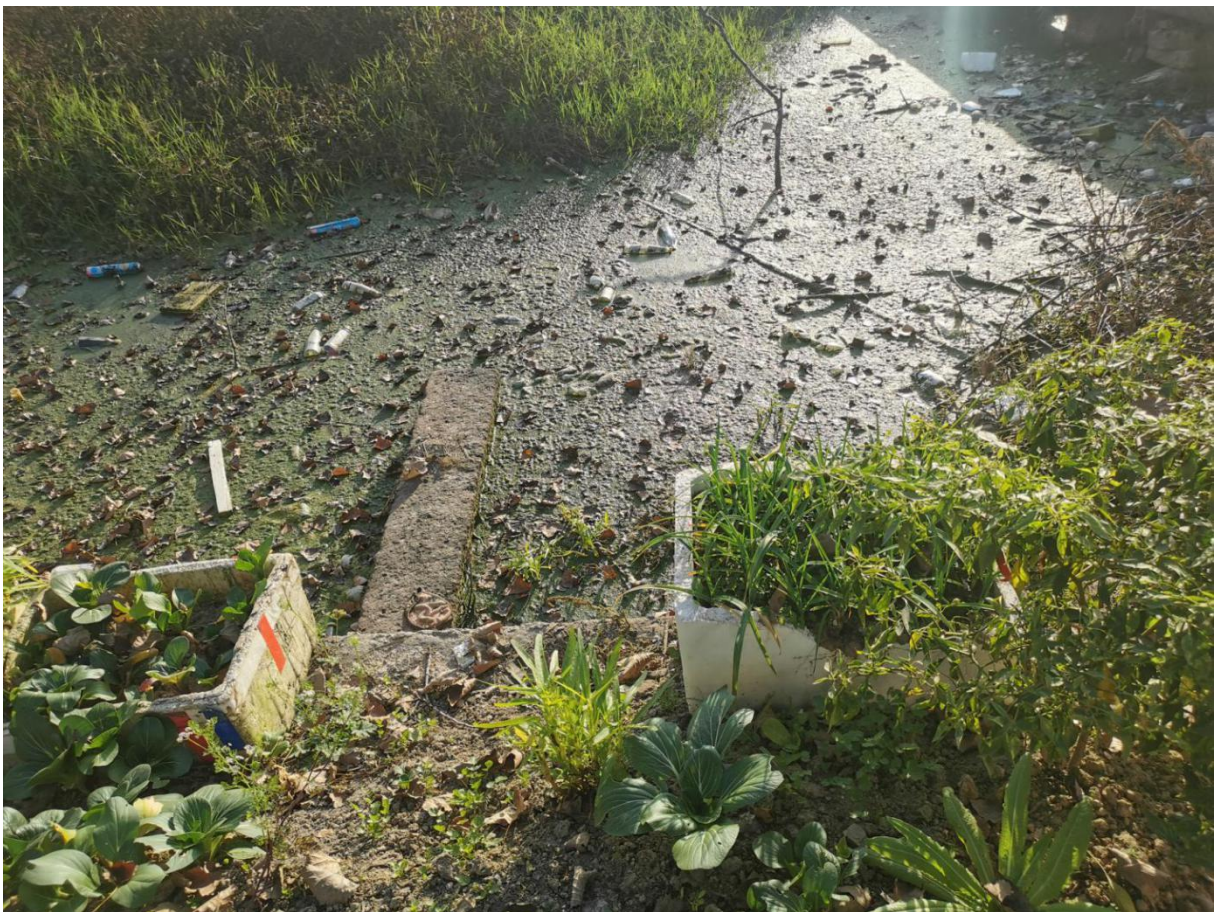
照片 018 王寨石桥 6
