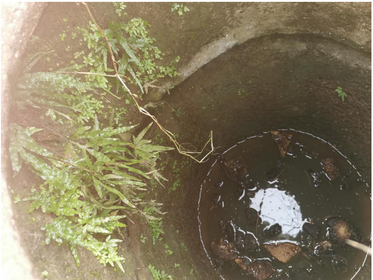
照片 006 杨杜水井 6
