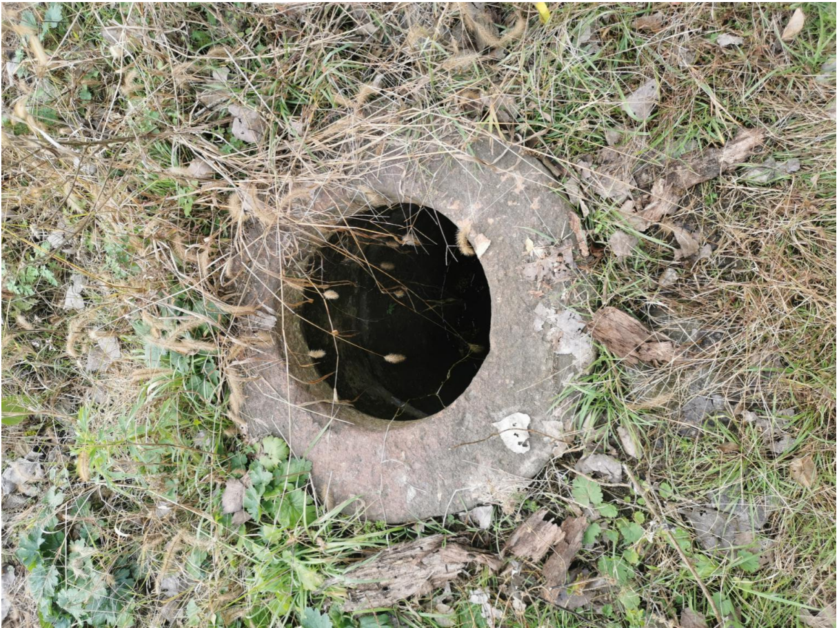
照片 004 杨杜水井 4
