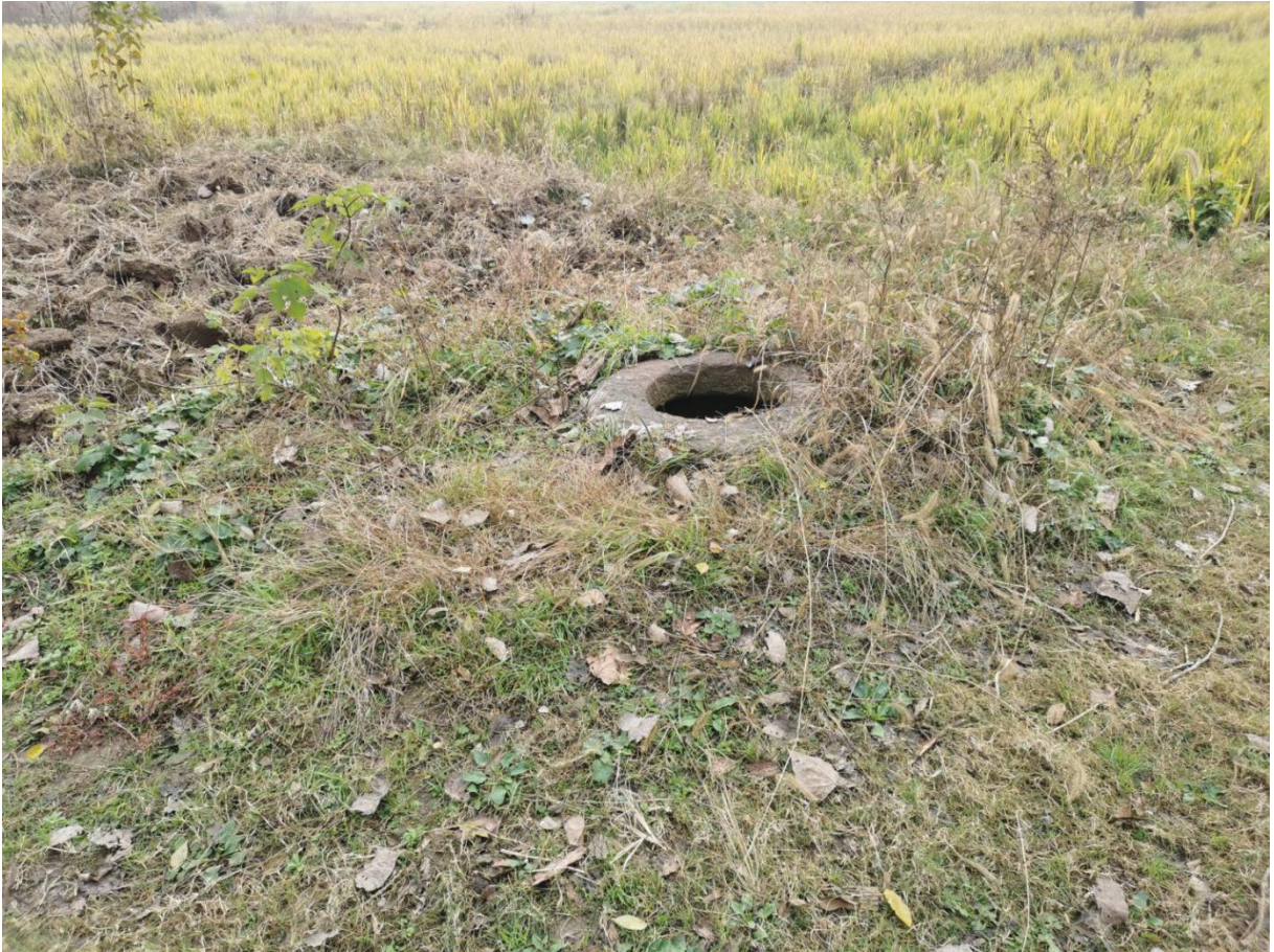
照片 003 杨杜水井 3
