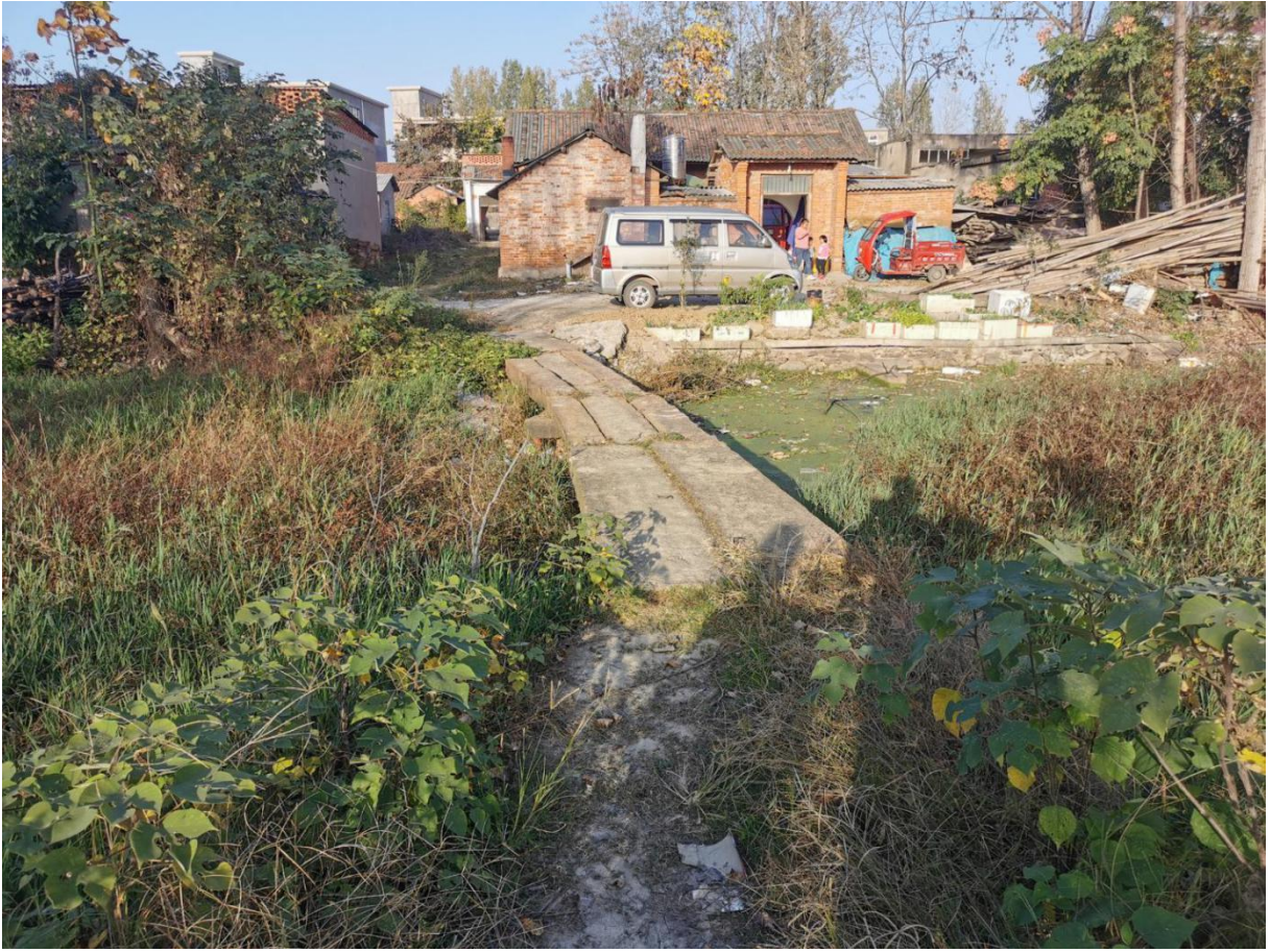
照片 015 王寨石桥 3
